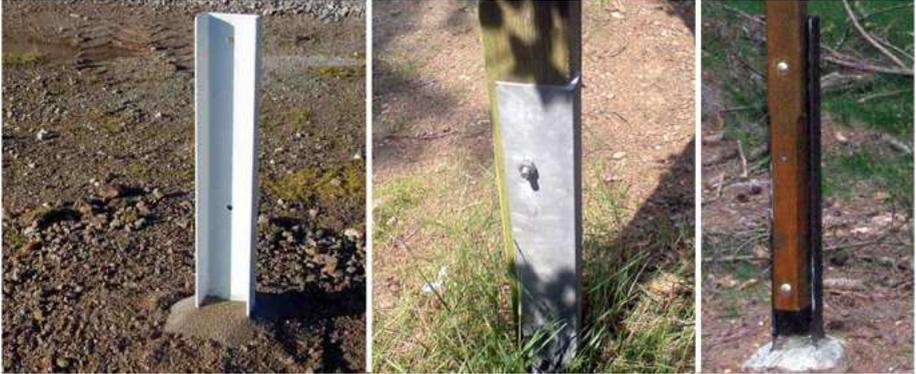
U-Profil mit Betonfundament (ca. 50 cm Tiefe); L-Profil mit angeschraubten Pfosten
